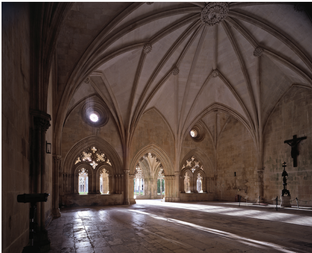
Fig. 2 – Sala do Capítulo, em último plano a parede norte. Luís Pavão/DGPC/ADF.
