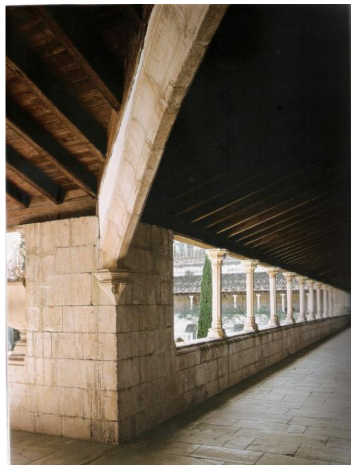
Fig.7 – Claustro de D. Afonso V – 2º piso.
