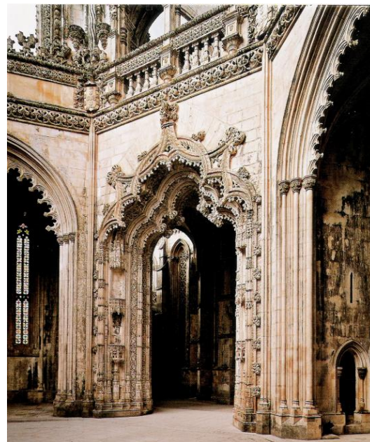
Fig. 8 - Capelas Imperfeitas – face interior do portal.
